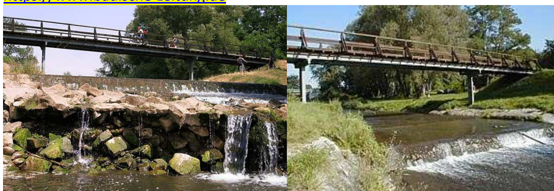
Confluence Kander – Rhin avant et après travaux.
